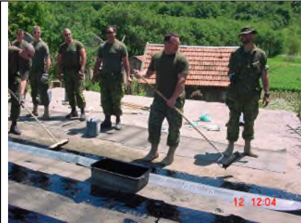
Membres de la troupe 43 lors de la réparation de toit Photo fournie par Guy Bériau
